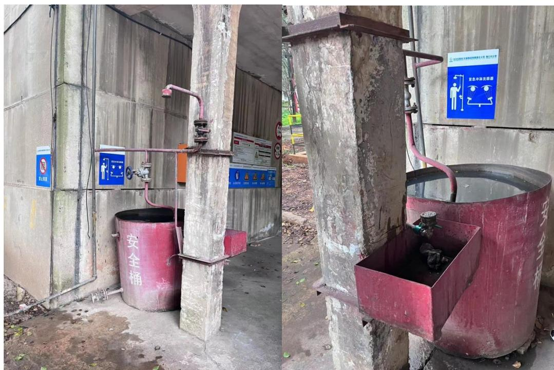
图 2-3 磷酸库洗眼、喷淋装置
